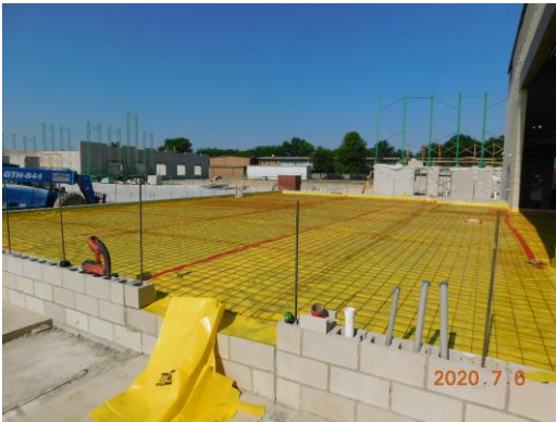
Stage floor concrete prepped for pour
